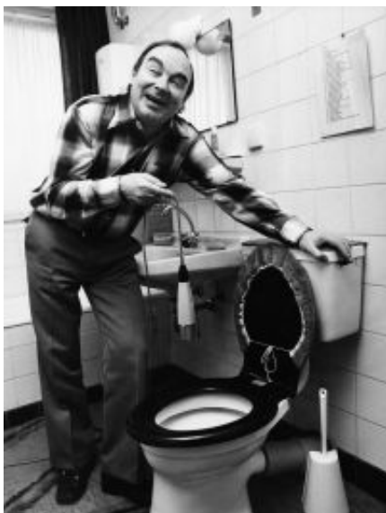
HH bei der Aufnahme der Klospülung
